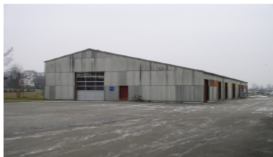
1 Halle industrielle composée de plaques ondulées en fibrociment
